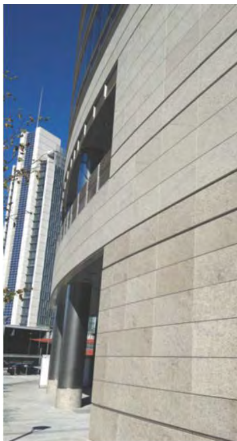
■ Parete di marmo, cantiere Porta Nuova (Milano)
