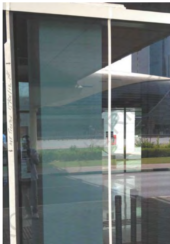
■ Vetrata ad alta performance installata su un edificio a Dubai
